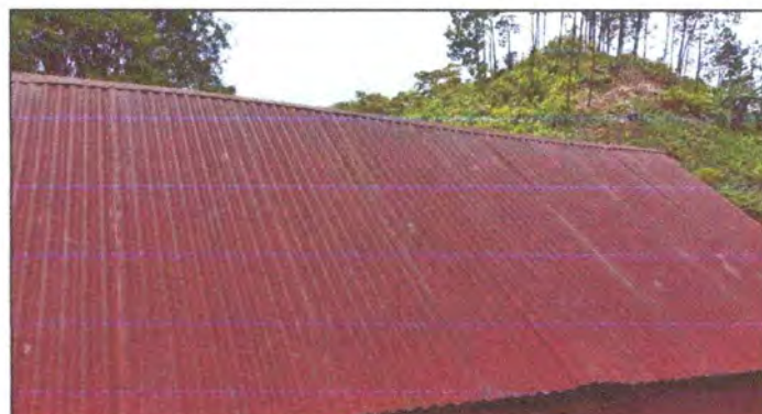
Foto 4: TECHO EN MAL ESTADO COMO SE MUESTRA EN LA FOTOGRAFÍA LA NECESIDAD DE REALIZAR SUSTITUCIÓN DE LAMINAS, MODULO 1.
