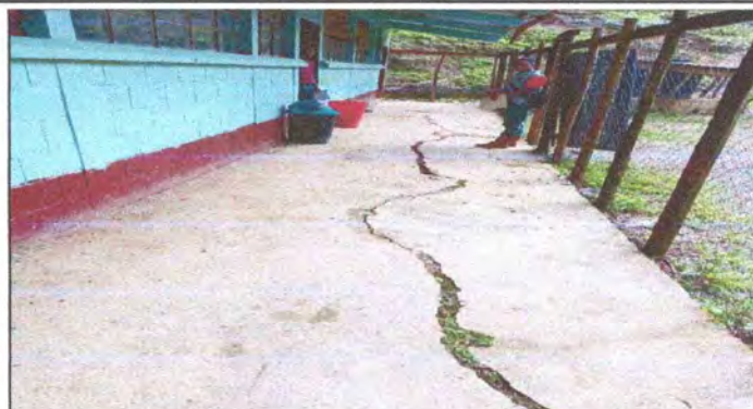
Foto 2: VISTA DEL CORREDOR EN MAL ESTADO. MEJORAMIENTO Y ALISADO DEL CORREDOR, MODULO 1.
