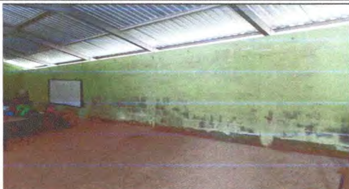
Foto 7: VISTA INTERNA DE PARED EN MAL ESTADO. APLICACIÓN DE REPELLO, MODULO 3.
